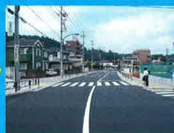
初沢踏切から国道20号方面を望む(改良後)
