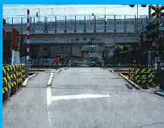
初沢踏切付近(改良前)
