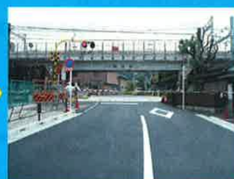
初沢踏切付近(改良後)
